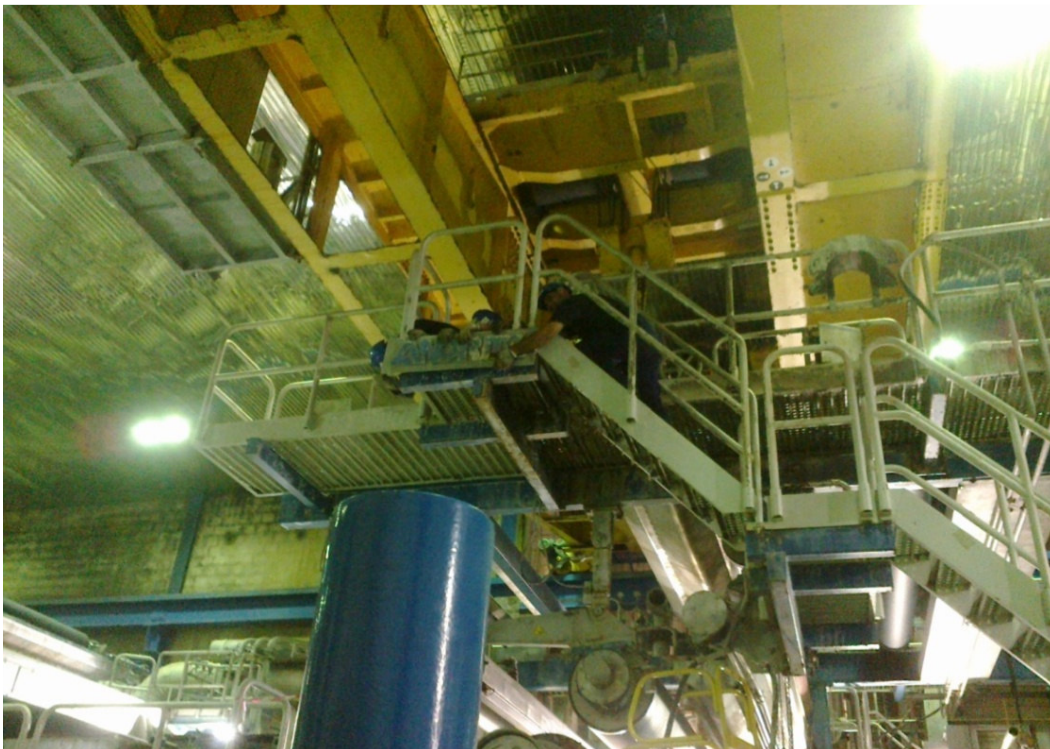
Figura 21 - Desmontagem das escadas das passerelles
