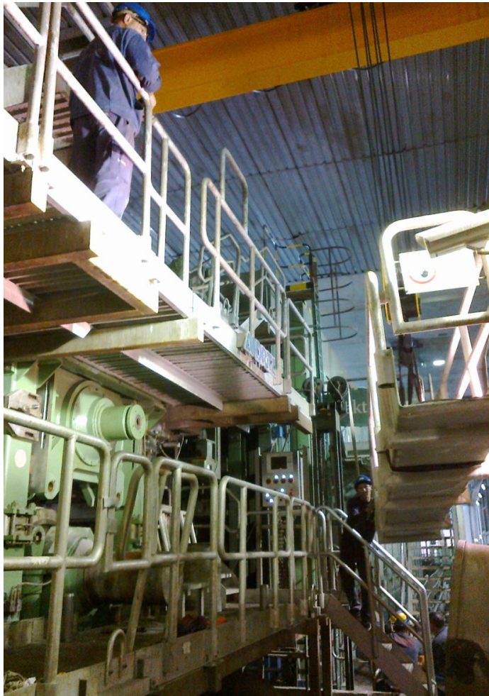
Figura 31 – Passerelle a ser transportada para ser recolocada no sítio devido
