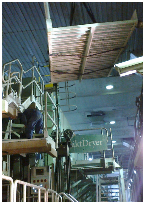
Figura 22 – Uma passerelle a ser retirada e a ser transportada
