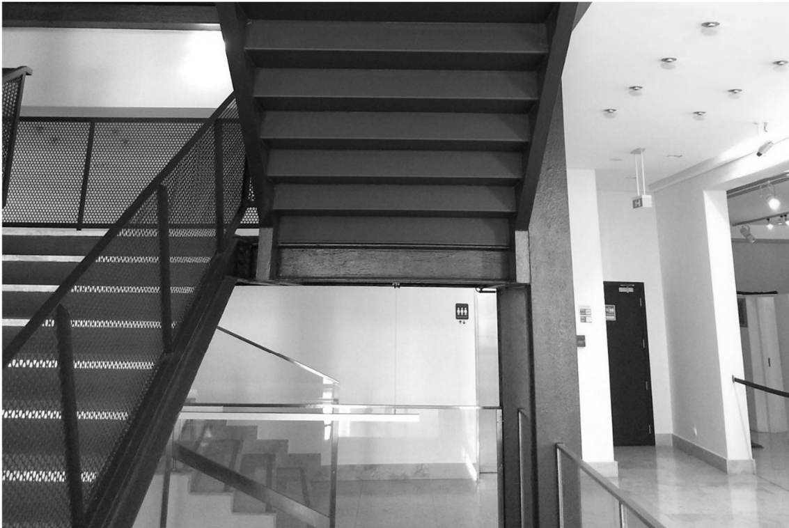
Figura 2 Teatro Municipal, Tempo [2021] Detalhe escada interior [obra de reabilitação]
