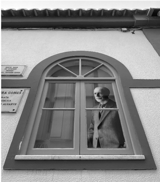
Figura 2 Casa Manuel Teixeira Gomes [2021] Janela em arco geminada
