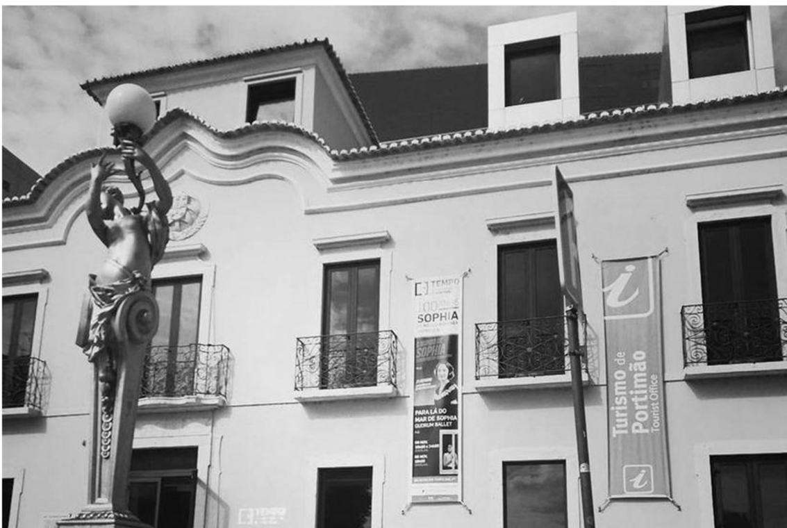
Figura 3 Teatro Municipal, Tempo [2021] Detalhe fachada
