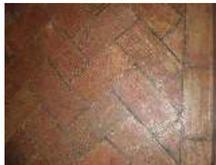
Fig.3.4.4 Ladrilho de barro colocado à meia-
