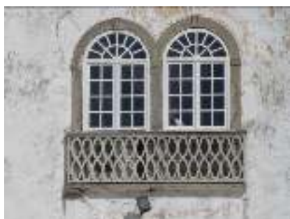
Fig.4.5.3.2 Sacadas e guarnições em cimento pré-moldado
