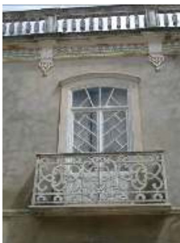
Fig.2.8.4 Nº 15 da rua 1º de Maio, Guardas em betão moldado
