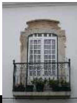
Fig.4.5.3.3 Sacadas em pedra com guarnição em ferro fundido e forjada
