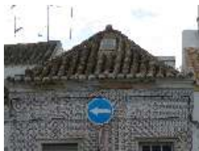
Fig.3.3.4.6 Telhado de tesoura
