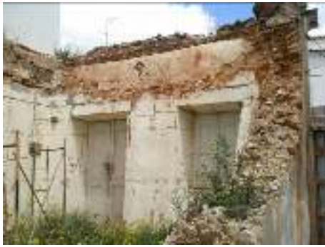
Fig.3.2.3 Alvenaria de taipa rodízio
