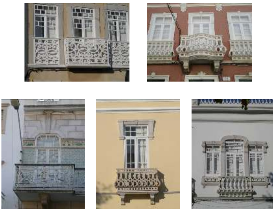
Fig.4.6.2.1 Guardas em betão pré-moldado
