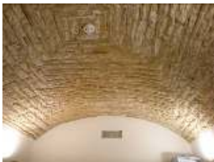
Fig.3.3.1.2 Abóbada em tijolo regional
