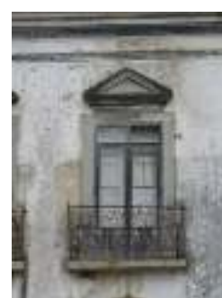
Fig.4.5.3.3 Sacadas em pedra com guarnição em ferro fundido e forjada
