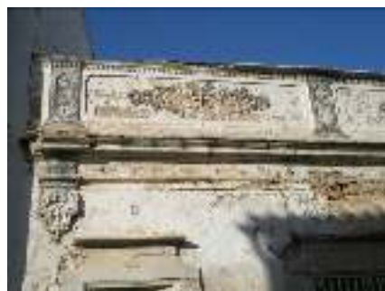
Fig.4.2.3.4 Beirado com platibanda
