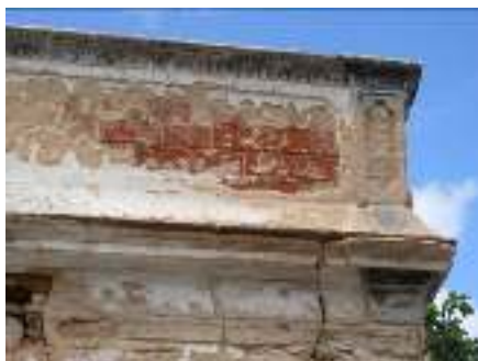
Fig.4.2.3.5 Tijolo maciço visível numa platibanda
