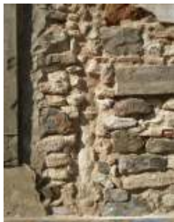
Fig.4.3.5 Tubo de queda embutido, em grés
