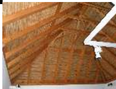
Fig.3.3.4.3 Estrutura de um telhado de tesoura
