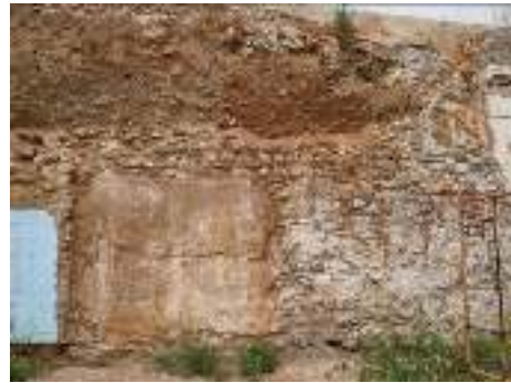
Fig.3.2.4 Alvenaria de taipa assente em alvenaria de taipa rodízio
