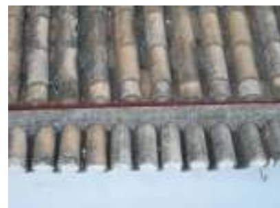
Fig.4.2.1.2 Beirado simples com caleira
