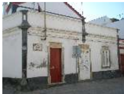
Fig.4.2.3.2 Platibanda
