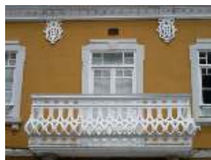
Fig.4.5.3.2 Sacadas e guarnições em cimento pré-moldado
