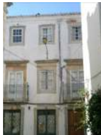
Fig.4.3.6 Tubo de queda na fachada, em grés
