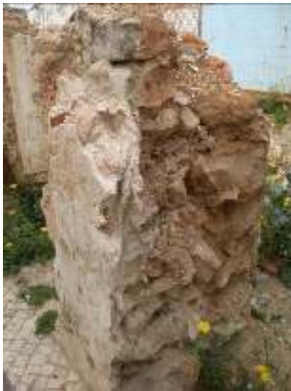
Fig.3.2.1 Parede mestra em taipa rodízio
