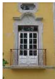
Fig.4.5.3.3 Sacadas em pedra com guarnição em ferro fundido e forjada
