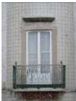
Fig.4.5.3.3 Sacadas em pedra com guarnição em ferro fundido e forjada
