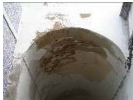
Fig.3.3.1.3 Arco em tijolo regional
