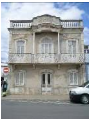
Fig.2.8.3 Nº 15 da rua 1º de Maio, Fachada edifício Arte nova
