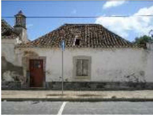
Fig.4.2.2 Beirado com cimalha
