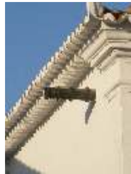
Fig.4.2.2.2 Duplo beirado no edificado de Tavira
