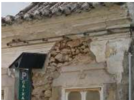
Fig.4.2.1 Pormenor de beirados simples com cimalhas
