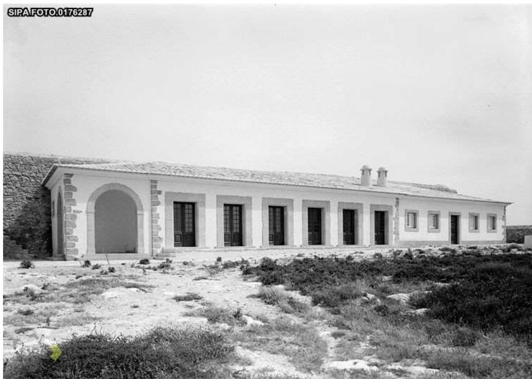
FIG. 12 – Fotografia do restaurante na fase final da construção – Final da década de 50 do século XX
