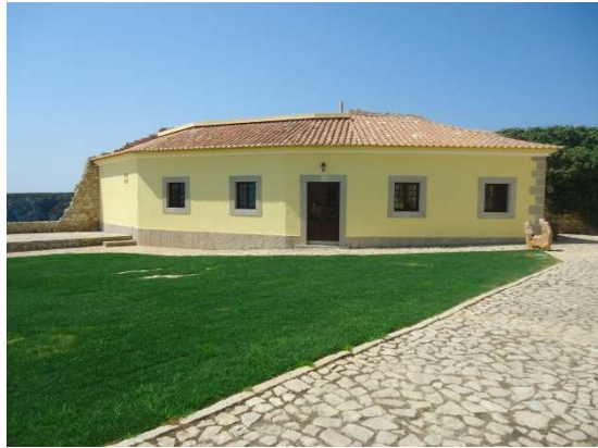
FIG. 26 – Fotografia do edifício de hospedagem.
