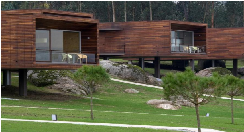
Figura 13 - Barragem de Castelo de Bode, Alojamento Turístico
