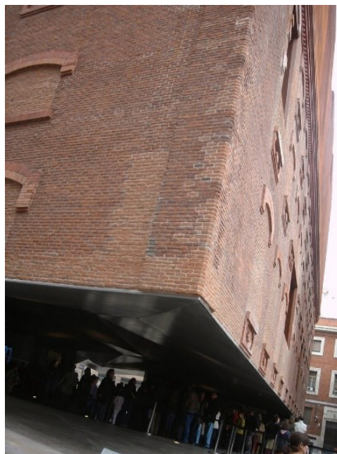
Figura 25- Vista da entrada.
