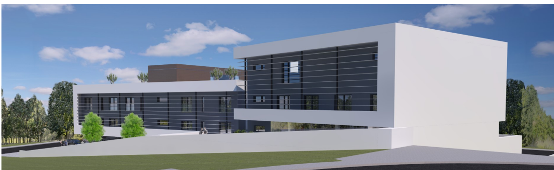
Fig. 54– Imagem do Exterior Alçado Sul/Nascente
