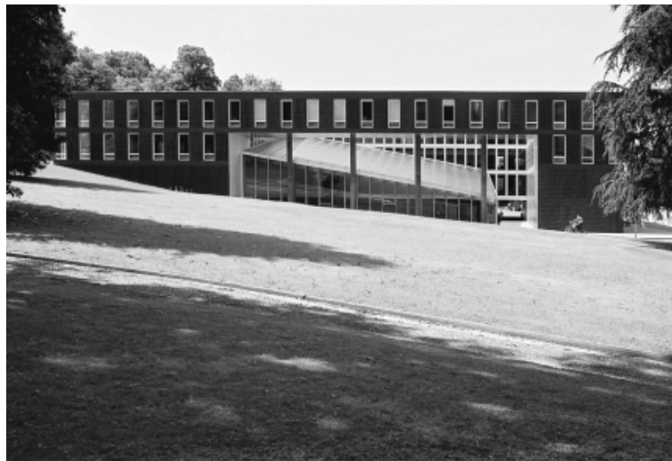
Figura 43 – Fotografia do Edifício misto.
