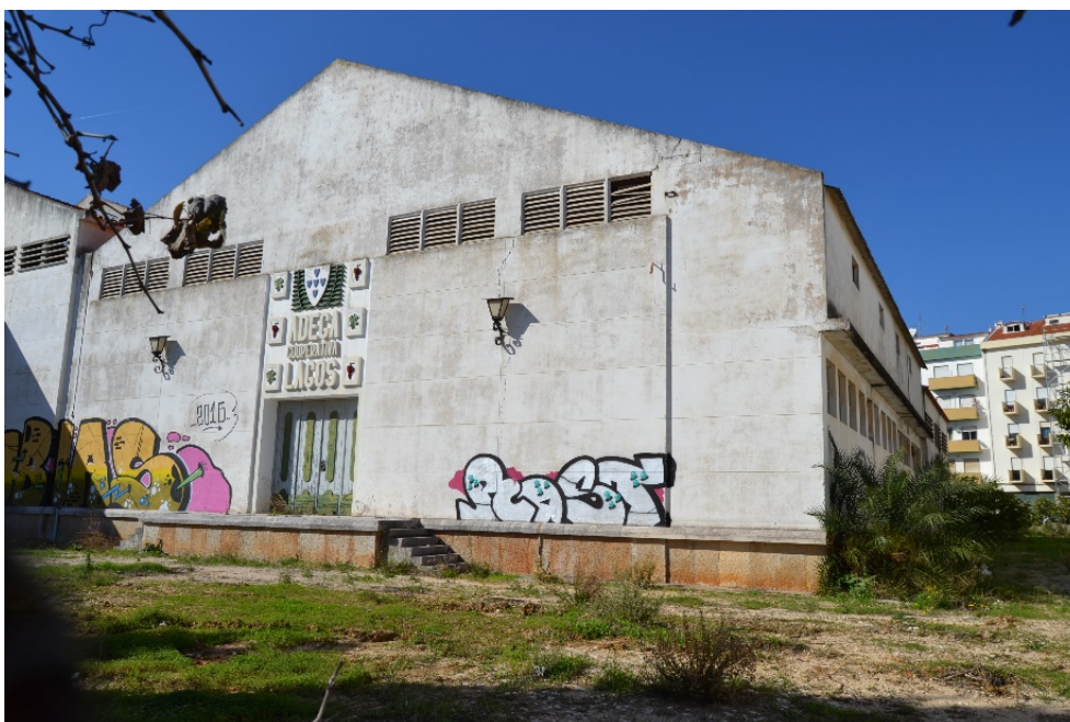
Figura 30 - Pavilhão da Adega Cooperativa de Lagos antes da demolição.
