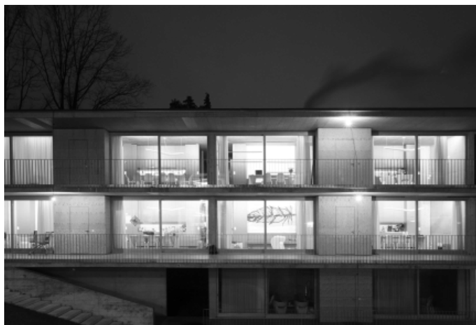
Figura 50 – Fotografia do edifício de apartamentos para estudantes.
