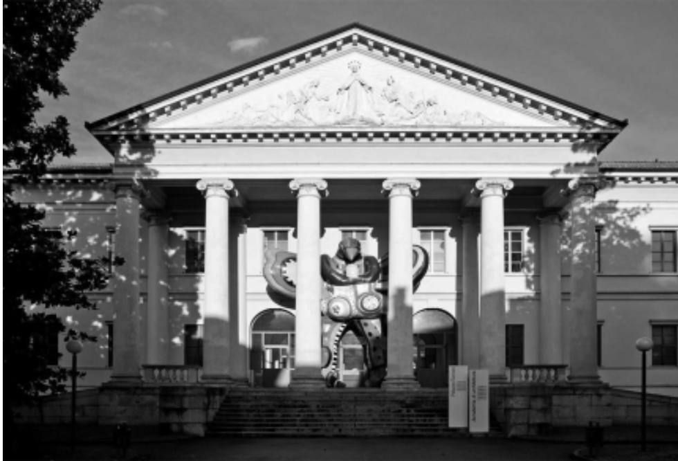
Figura 39 – Fotografia da Fachada Principal do Edifício.
