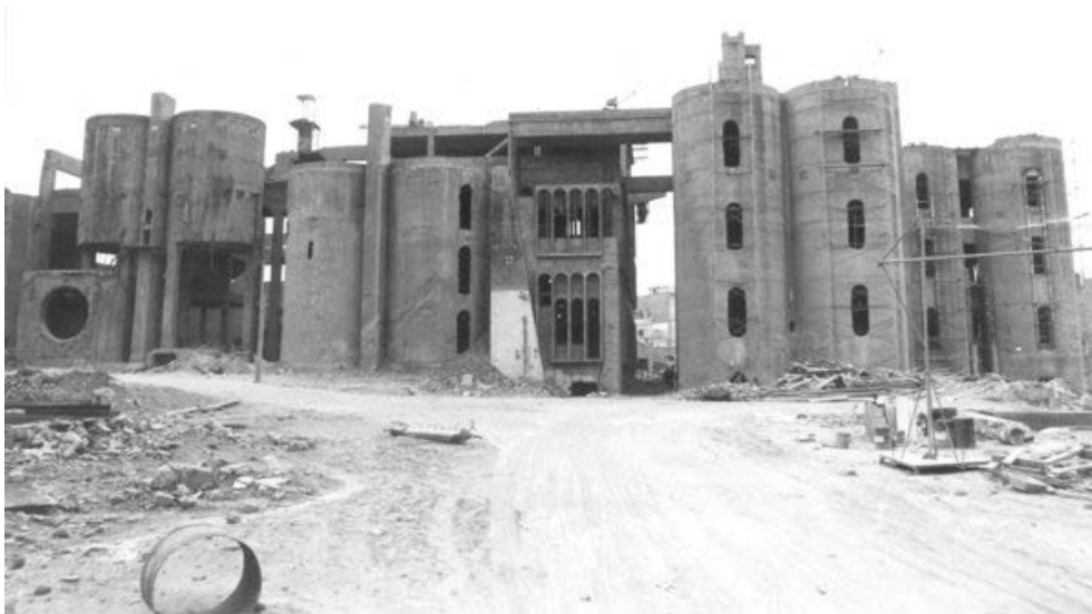
Figura 33 - Demolição de alguns elementos da Fábrica.
