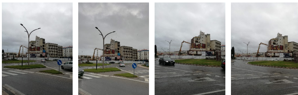
Figura 28 - Registo fotográfico da demolição total do Hotel S. Cristóvão, Janeiro de 2018.
