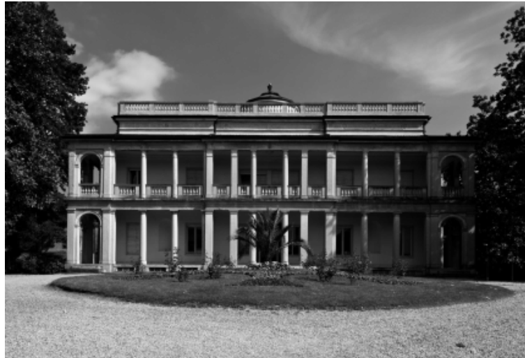
Figura 46 – Fotografia da fachada do edifício.
