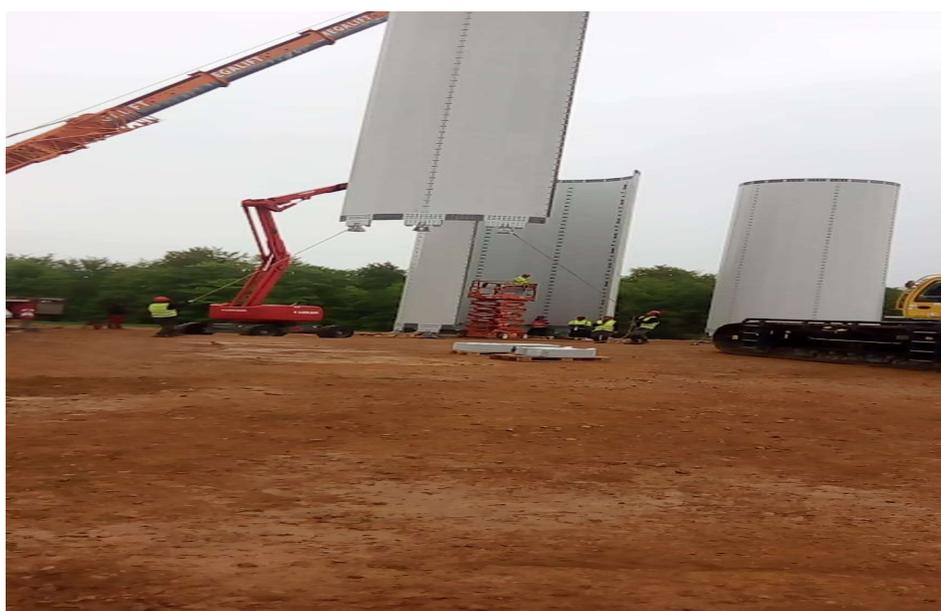
Figura 10 - Montagem do corpo da Turbina
