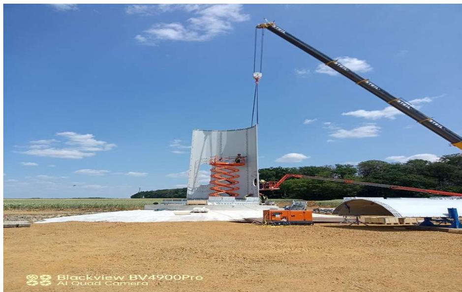
Figura 9 - Montagem da Base da Turbina
