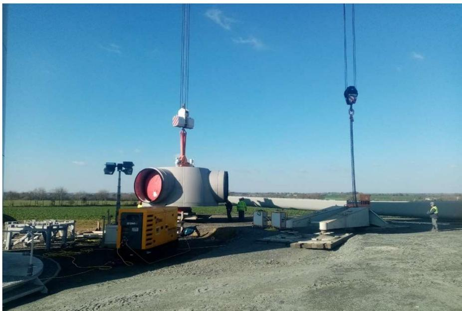
Figura 12 - Elevação da estrutura que sustenta as pás
