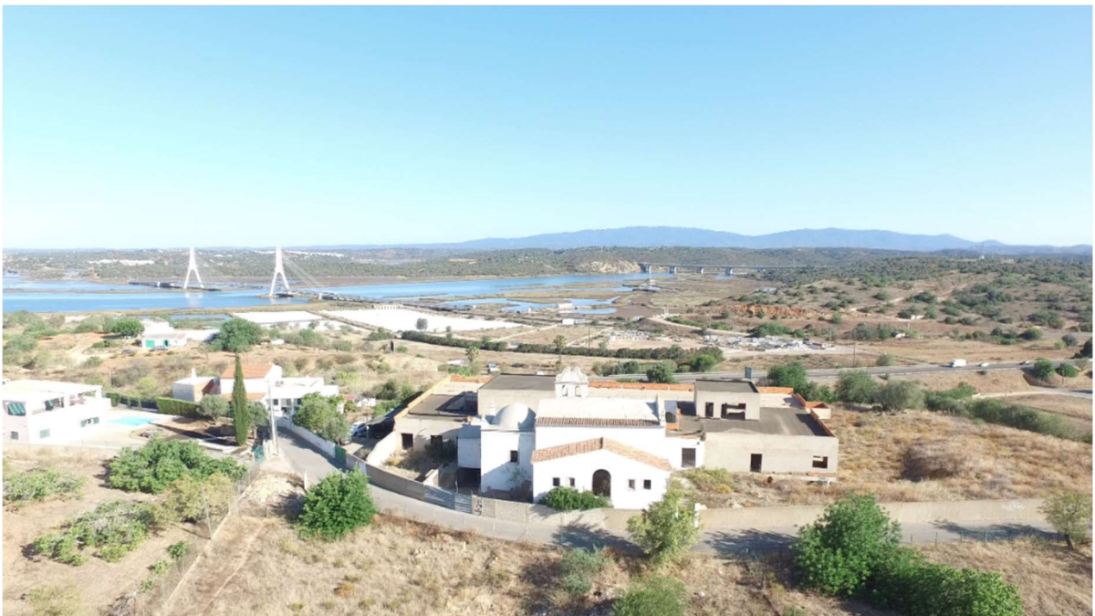
Figura 22 - Vista do Convento de Praxel, de autor.
