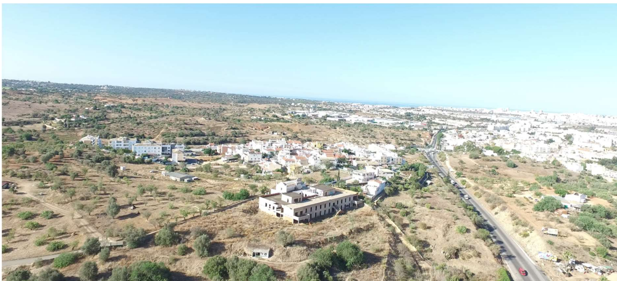
Figura 2 - Vista do Convento de Praxel, de autor.
