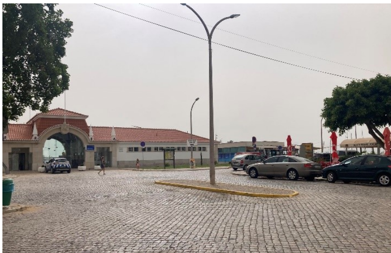
Figura nº10, Zona de Intervenção - zona sul , Autor, 2023.
