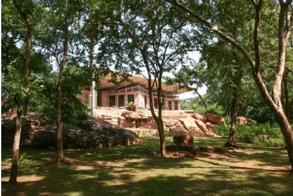
Figura 22 – Parque Nacional do Mali – República do Mali – Arquiteto Diébédo Kéré (2010). Fonte: https://www.dezeen.com/2022/03/15/diebedo-francis-kere-projects-roundup-architecture/
