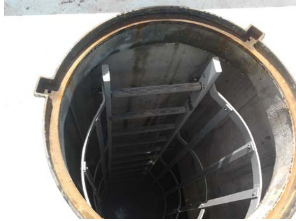
Foto 4 Caixa de conduta de água
