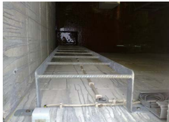
Foto 2 Caixa com medição de caudal em conduta
