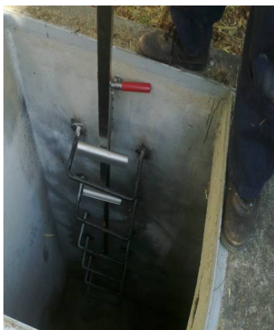
Foto 8 Colocação do dispositivo nos degraus
