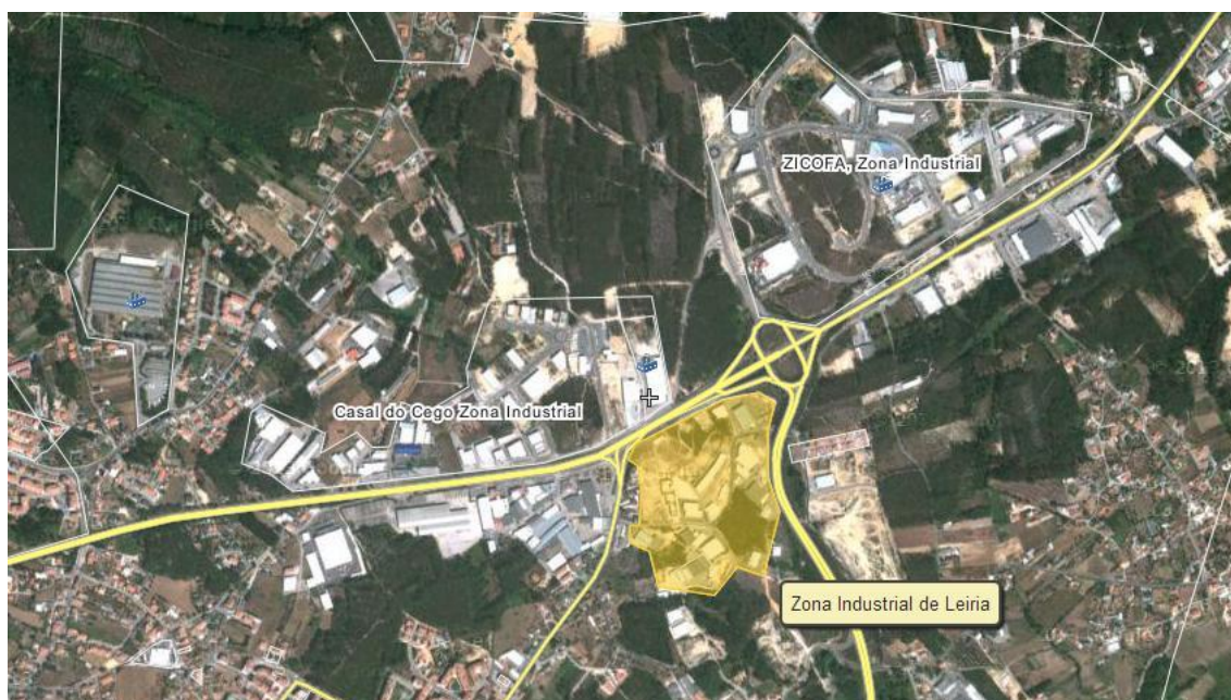
Figura 3.1 Zona Industrial de Leiria.
