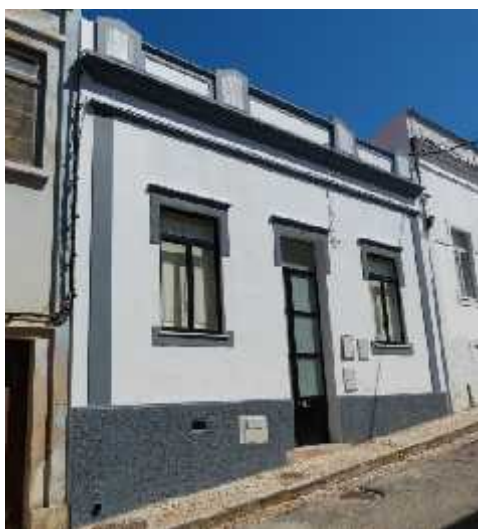
Figura 32 – Edifício de piso térreo com platibanda, revestido com argamassa
