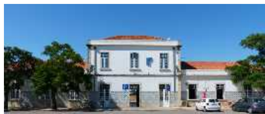
Figura 45 – Estação ferroviária de Portimão
