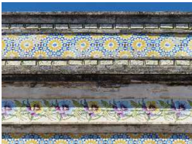
Figura 28 – Platibanda decorada, com a utilização de azulejos
