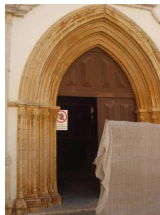
Figura 94: Porta da entrada principal.
