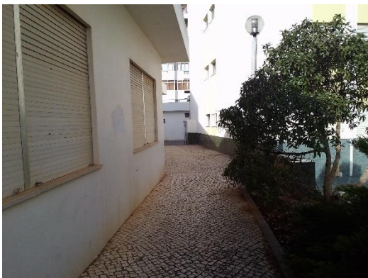
Figura 54: Vista das janelas das salas de catequese.
