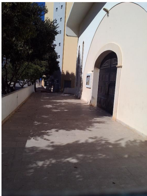
Figura 51: Entrada principal da Igreja.
