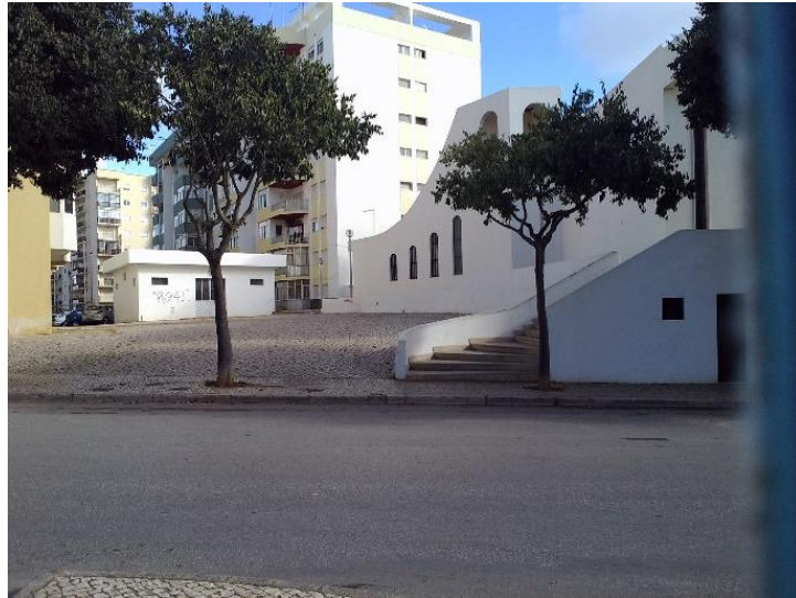
Figura 53: Vista do espaço aberto com o acesso da Rua N a S a do Amparo.
