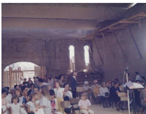
Figura 60: Celebração no edifício ainda em obra.
