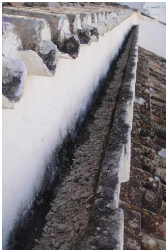
Figura 96: Caleira obstruída.
