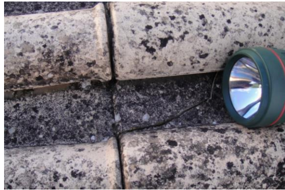
Figura 97: Telha rachada.
