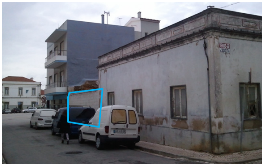
Fig. 58 - Fotografia do Alçado Frontal do terreno existente. Fonte: Fotografia de Francisco Tavares
