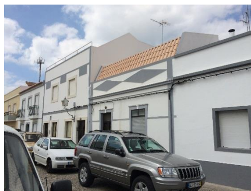
Fig. 111 - Edifício existente na Rua Almirante Cândido dos Reis, n.º 143 – Exemplo negativo de reabilitação de uma cobertura.
