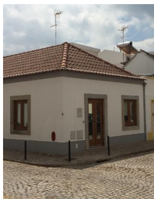
Fig. 113 - Edifícios existentes no gaveto da Rua General Humberto Delgado e Rua Almirante Cândido dos Reis – Exemplo negativo na aplicação das caixas de infraestruturas.
