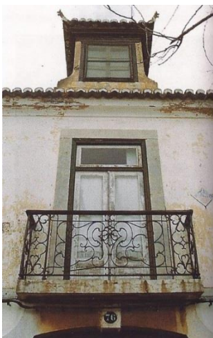
Fig. 83 – “Relação entre o portal da Sociedade, a janela de sacada e a trapeira.”; “Pormenor, de um vão de sacada, com caixilho e taipal interior e gradeamento em ferro.”
