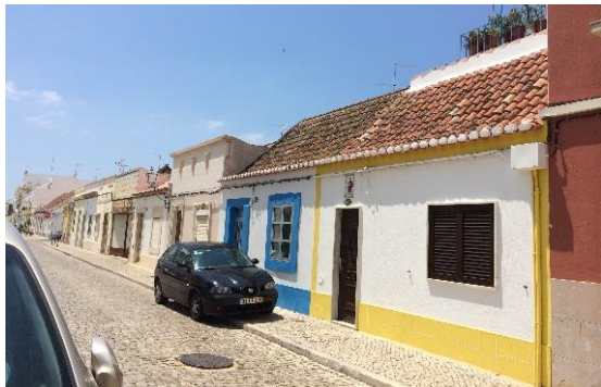
Fig. 109 - Edifícios existentes na Rua da Princesa, n.º 103 e n.º105. Indicação da diversidade cromática existente.
