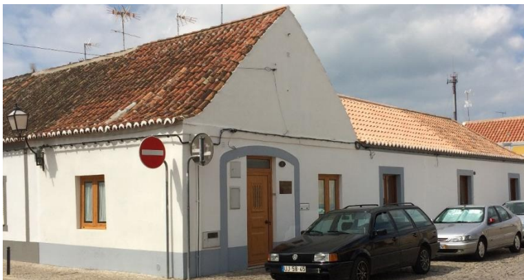
Fig. 102 - Edifício existente situado no gaveto da Rua Dr. Manuel Arriaga e Rua da Princesa – Classificação E4 de acordo com o PPS.NP.VRSA. Este caso em particular até é mais relevante, pois encontra-se na ZIS.
