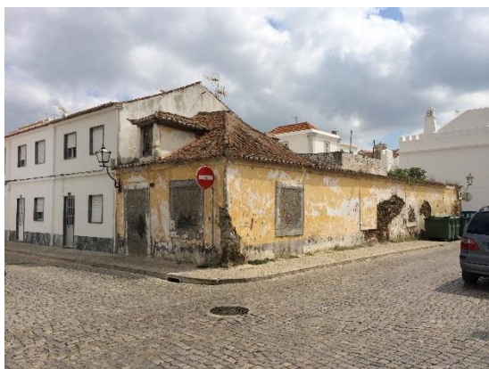
Fig. 119 - Edifício existente na Rua Dr. Manuel de Arriaga – Exemplo de uma construção com 1 piso + Sótão. (edifício original completamente abandonado)
