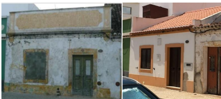
Fig. 92 - Edifício antes e depois de reabilitação, Rua Dr. Sousa Martins, n.º 21 – Classificação P2, de acordo com o PPS.NP.VRSA.
