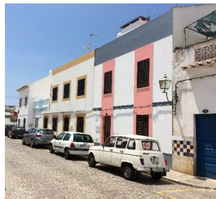
Fig. 116 - Edifícios existentes na Rua Barão do Rio Zêzere – Exemplo de construções relativamente recentes, com 2 pisos + Sótão.
