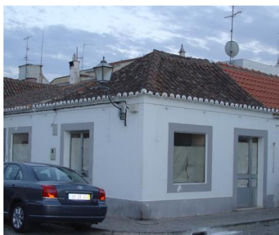
Fig. 99 - Edifício sem reabilitação, situado na Rua José Barão n.º42 - Classificação P2 de acordo com o PPS.NP.VRSA.
