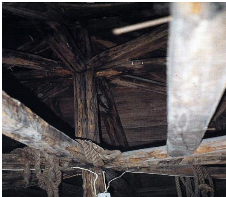
Fig. 86 – “Estrutura de cobertura do torreão Norte. Pormenor dos anéis em madeira.”
