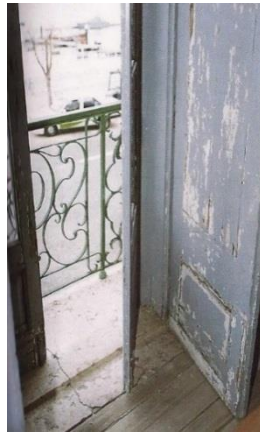
Fig. 82 – “Batente de uma porta na Praça Real.” e “Pormenor de um vão de sacada, com caixilho e taipal (corta sol) interior e gradeamento em ferro ( igual em todos os edifícios)
