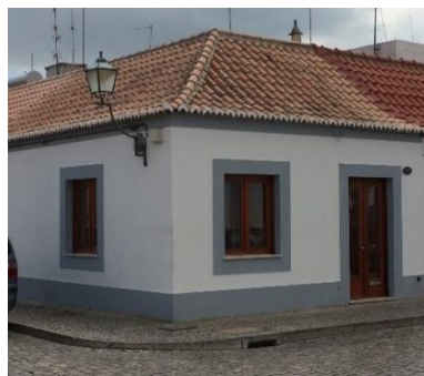
Fig. 100 - O mesmo edifício agora reabilitado ao abrigo do PPS.NP.VRSA
