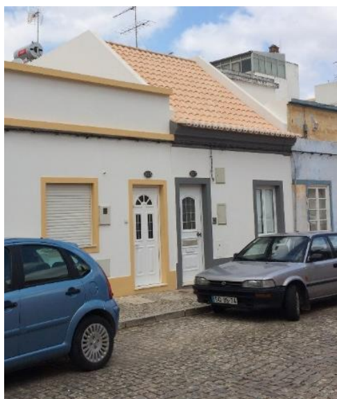
Fig. 117 - Edifício reabilitado ao abrigo do PPSNPVRS, situado na Rua Dr. Sousa Martins, n.º127 – Classif. E4 de acordo com o PPS.NP.VRSA. Cobertura inclinada na frente e plana nas traseiras.
