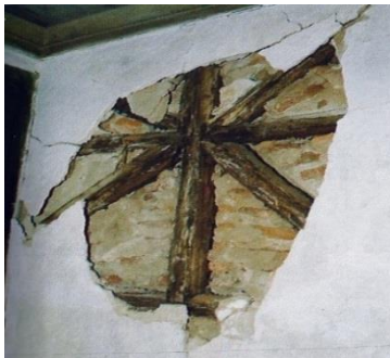
Fig. 80 – “Construção tipo gaiola conforme método construtivo utilizado na Baixa Pombalina em Lisboa - Alfândega.”
