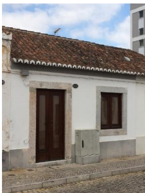
Fig. 112 - Edifícios existentes na Rua Dr. Sousa Martins n.º111 – Exemplo negativo na instalação de um armário elétrico.
