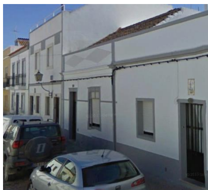
Fig. 110 - Edifício existente na Rua Almirante Cândido dos Reis, n.º 143 – Edifício sem reabilitação.
