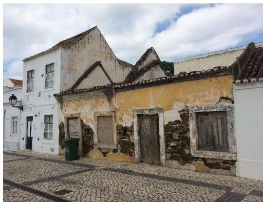
Fig. 120 - Edifício existente na Rua Jornal do Algarve – Exemplo de uma construção com 1 pisos + Sótão. (edifício original, com algumas adulterações na cobertura, e completamente abandonado)
