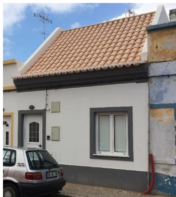
Fig. 98 - O mesmo edifício agora reabilitado ao abrigo do PPS.NP.VRSA
