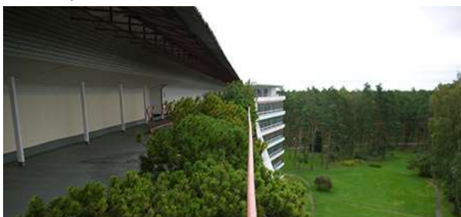
FIGURA 17 | Sanatório de Paimio - Vista do terraço.
