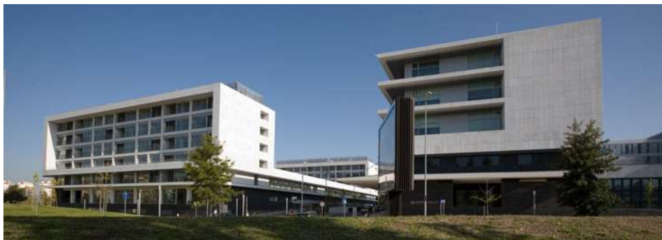
FIGURA 28 | Hospital da Luz - entrada.
