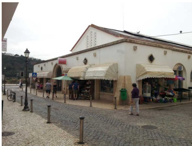
Figura 79 – Rua José Estevão, plataforma ao nível dos passeios delimitados por pinos, Mercado Municipal de Silves.
