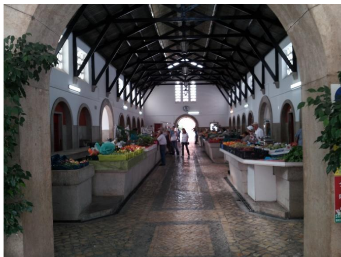
Figura 82 – Interior do Mercado Municipal de Silves, zona da “nave”, duplo pé-direito.
