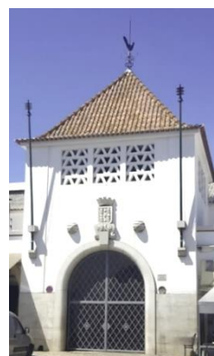
Figura 51 – Torreão do Mercado Municipal de Silves, fachada sul. Definido no presente trabalho como o Elemento Fundador.
