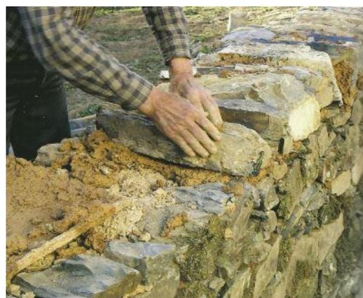
Fig. 61 Alvenaria. de xisto com argamassa de barro
