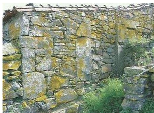
Fig. 62 Alvenaria. de xisto com pedras de grande porte para reforço de cunhal.
