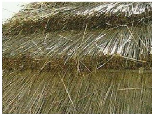
Fig. 59 Revestimento. de cobertura. Cónica em feixes de Palha de centeio
