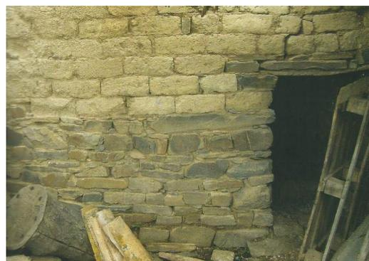
Fig. 64 Parede de Adobe com embasamento em Alvenaria. de xisto.
