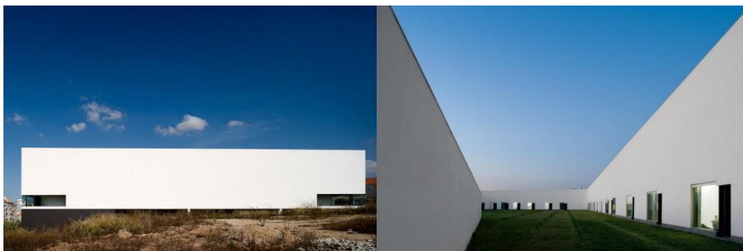
Figura 22 – A - Fachada lateral; B - Pátio interior
