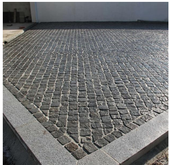
Figura 46 - Ligação calçada portuguesa e lajeta em pedra
