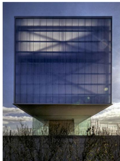
Figura 48 - Aplicação de placas de polycarbonato na fachada de edifícios
