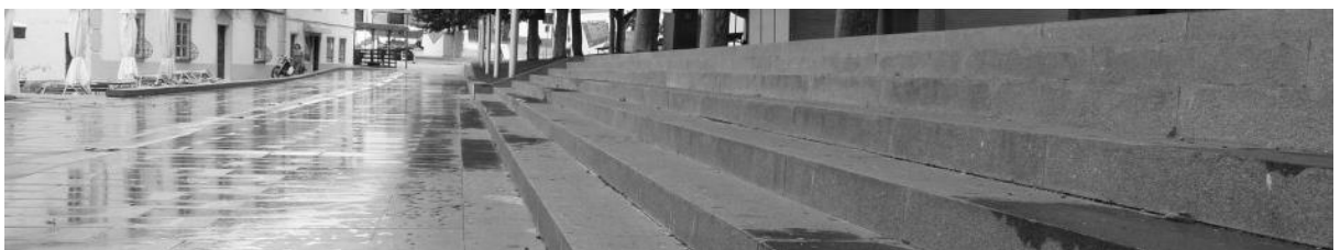
Figura 47 - Lajetas retangulares em pedra
