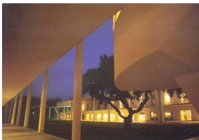
Figura 14 – Fachadas Interiores do edifício
