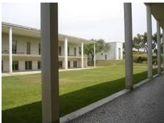
Figura 15 – Fachadas Interiores do edifício
