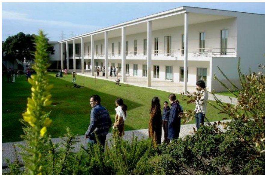
Figura 10 – Fachada Interior do edifício
