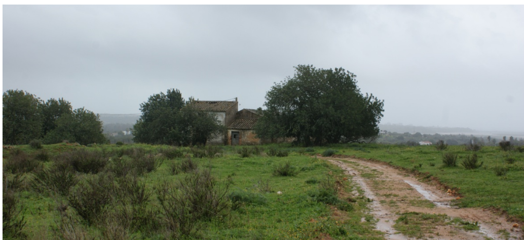
Fig. 12. Fotografia da Ruína existente 13
