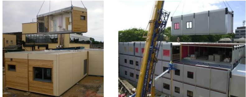
Ilustração 53 - Exemplos do sistema modular parcialmente abertos, “Designbuildsource” (à esquerda) e “SteelConstruction” (à direita) Fonte: www.steelconstruction.info/Modular_construction e www.pinterest.com , acedido em Fev de 2014
