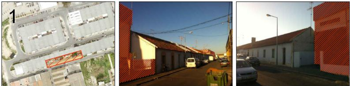
Ilustração 33 - Identificação Aglomerado habitacional, designado por bairro da caixa - VRSA
