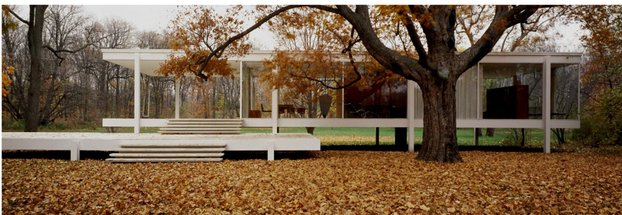
Fig. 14 – Mies Van der Rohe , Residência Farnsworth , Illinois, E.U.A., 1945-1951.
