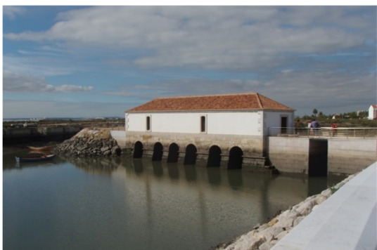
Fig. 11 – Moinho de Maré do Cais da Aldeia Galega , Montijo, Portugal, anterior a 1646.
