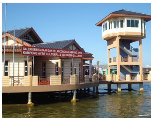
Fig. 6 - Construção recente com estrutura em betão (Kampong Ayer), actualidade.
