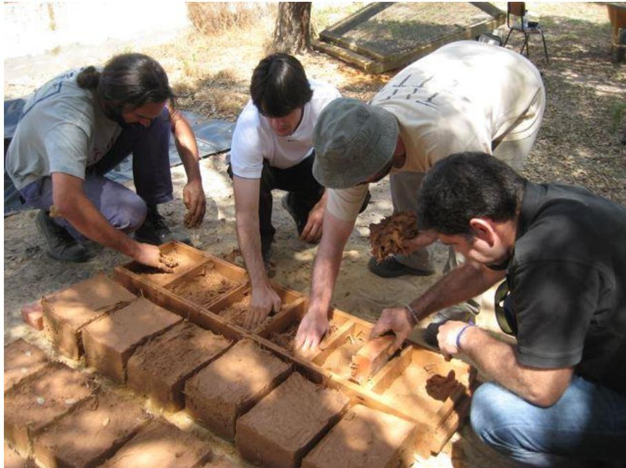
Fig. 12 - Disposição dos blocos de adobe para exposição solar
