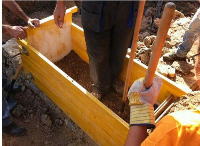
Fig. 14 - Workshop de construção em taipa, em Aljezur
