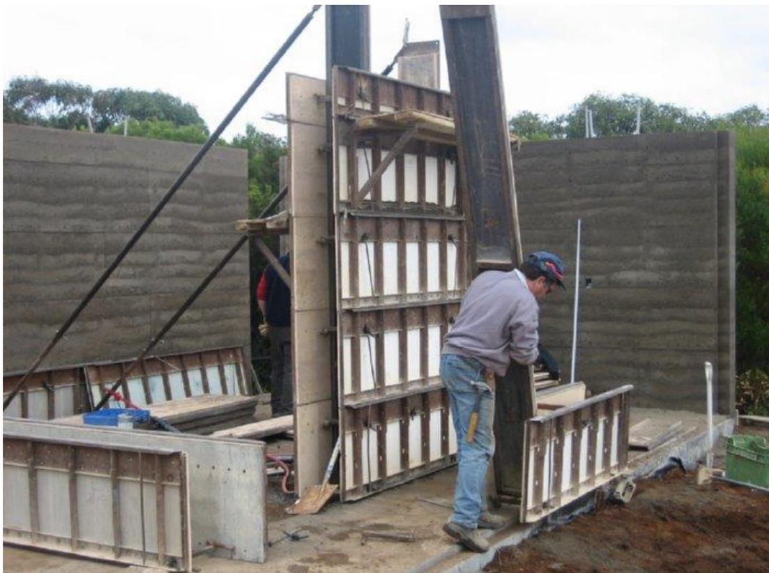
**Fig. 33 - Utilização de Taipais com estrutura metálica.**
