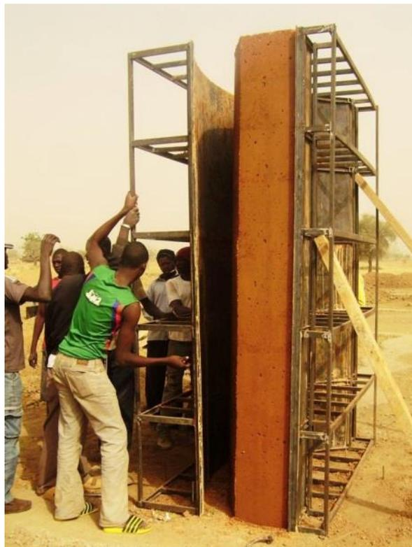
Fig. 52 - Sistema de taipal utilizado na construção das paredes da Escola secundária em Gando.
