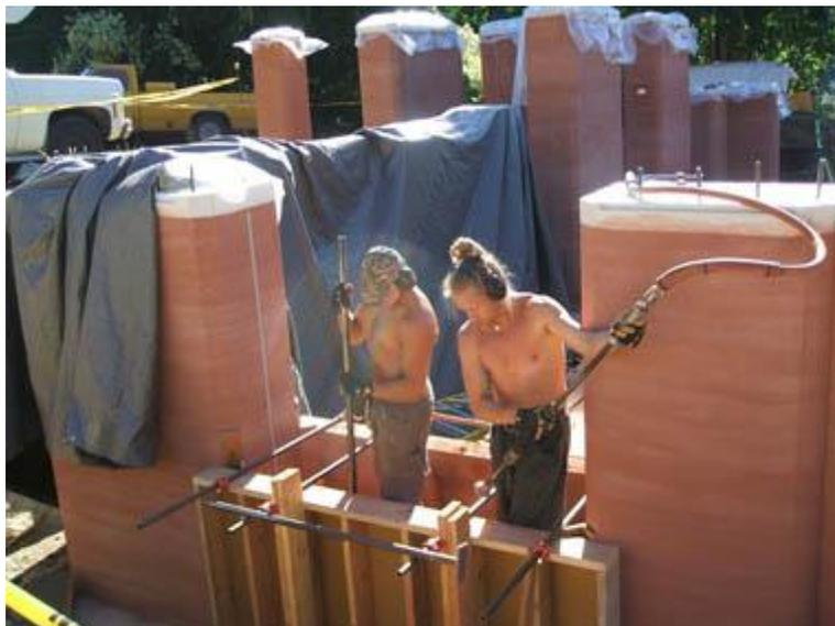
Fig. 31 - Utilização equipamento de apoio martelo de compactação
