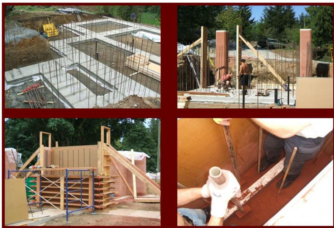
Fig. 32 - Evolução do sistema de construção em taipa, com utilização fundação em betão.
