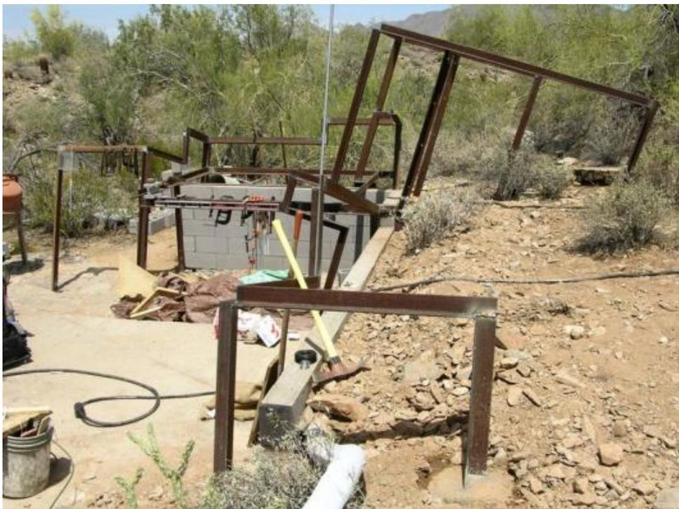
Fig. 75 - Liga de Ferro par definição das paredes de taipa
