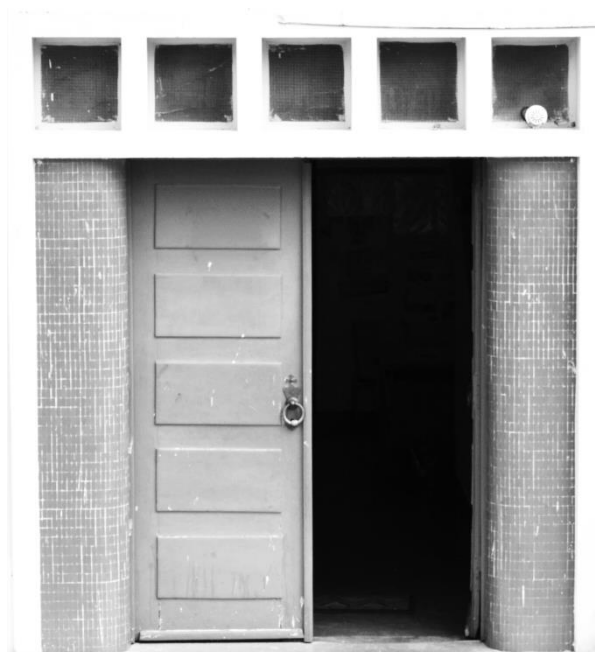
Fig. 9 – Porta do edificio principal da EB1 de Lagoa - Fonte: FAD
