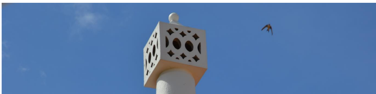
Fig. 12- Imagem de uma das chaminés do edifício principal. Fonte: FAD
