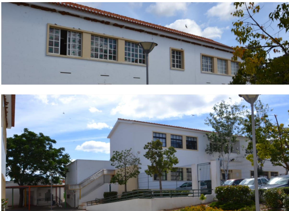
Fig. 10 – Fachadas do edifício principal e cantina da EB1 de Lagoa - Fonte: FAD
