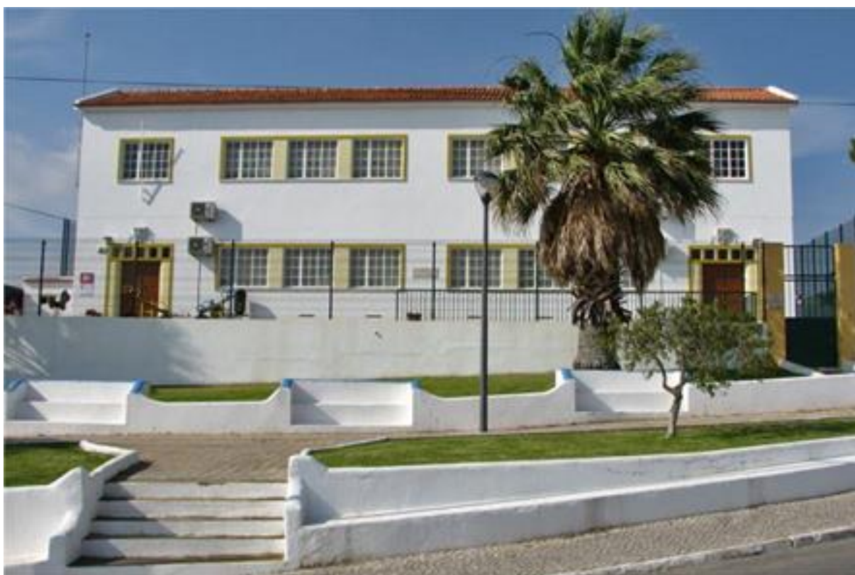
Fig. 19 - Imagem da fachada Sul da EB1 de Carvoeiro. Fonte: CML
