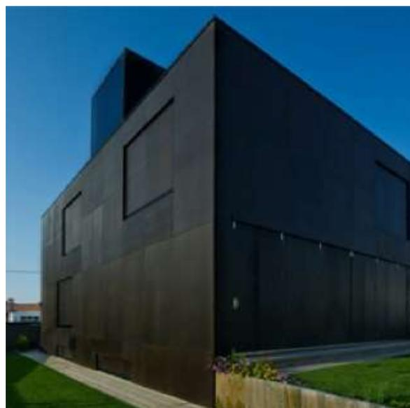
figuras 127 e 128 | aplicação de placas HPL, do tipo TRESPA Meteon Lumen
