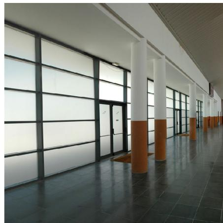
**Fig. 4.16** - Fotografia do envidraçado translúcido na fachada Poente. (GML)
