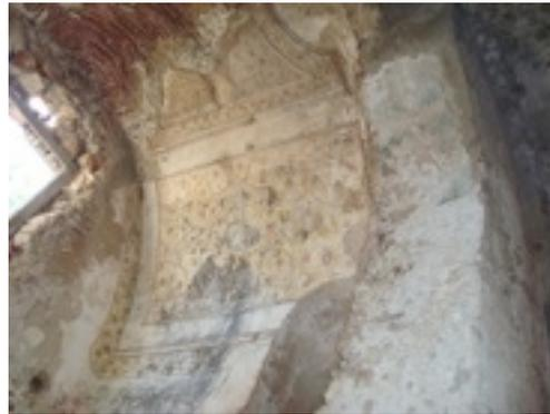
Fig. 30 - Revestimentos a escaiola
