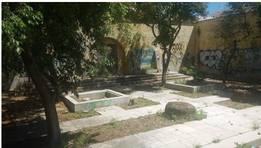
FIG. 5.5 – PÁTIO INTERIOR VIRADO A SUL, GRÉMIO DOS INDUSTRIAIS DE CONSERVAS DE PEIXE DO SOTAVENTO ALGARVIO
