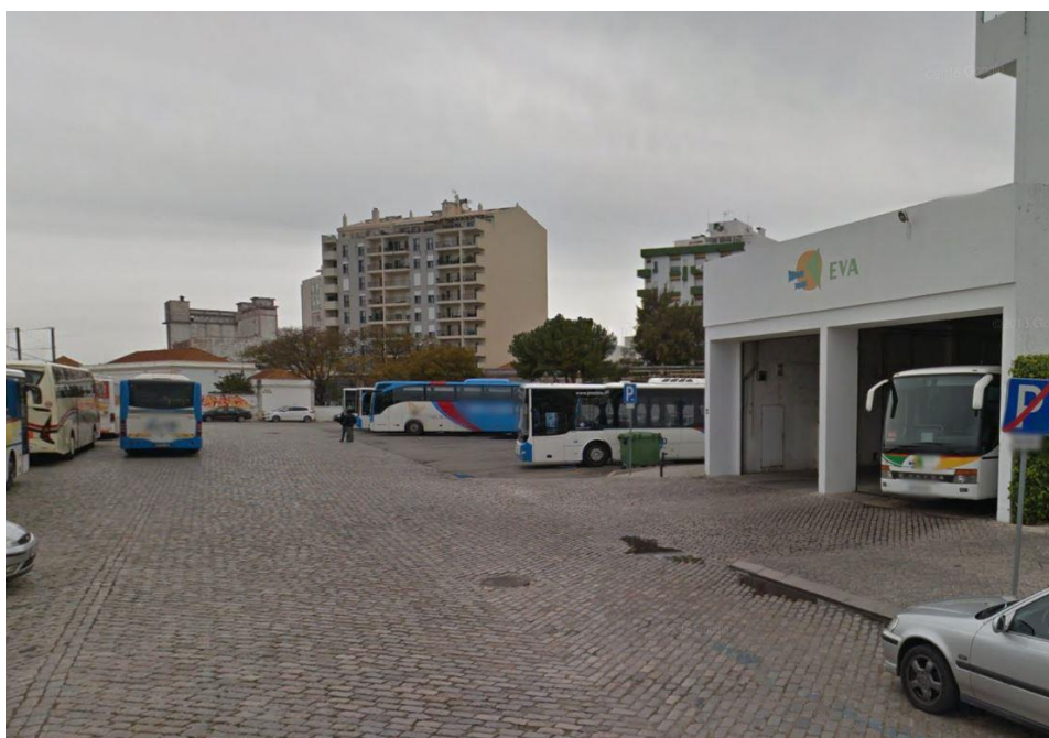
Fig. 3.13 – EXTERIOR DA ESTAÇÃO RODOVIÁRIA DE FARO – ZONA DE RECOLHA E MANUTENÇÃO
