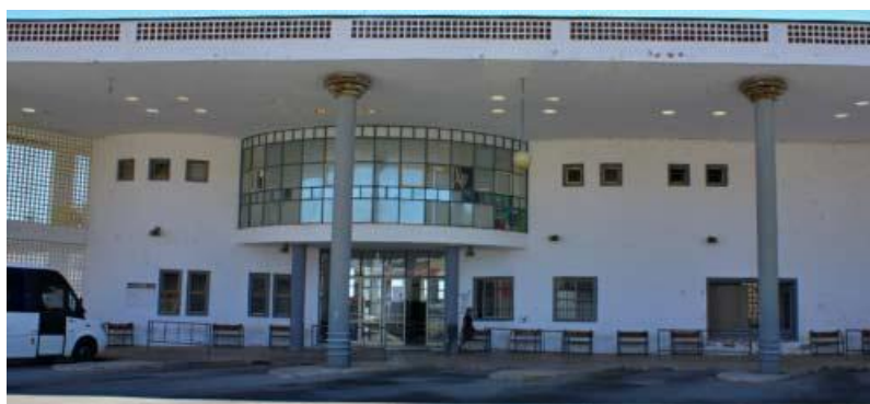
Fig. 3.15 – TERMINAL RODOVIÁRIO DE TAVIRA – PLATAFORMAS
