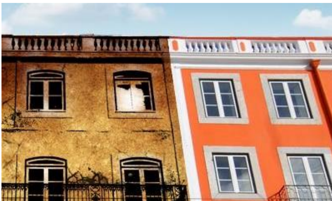
FIG. 2.1 – ASPECTO VISUAL DE UM EDIFÍCIO REABITADO E OUTRO NÃO REABILITADO.
