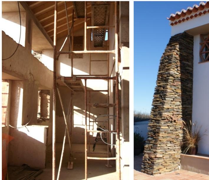
Fig. 123 - Aspecto do expressivo contraforte em pedra de xisto, tecnicamente bem executado, com junta aberta sem argamassa à vista. [Fonte: Autor, 2014]
