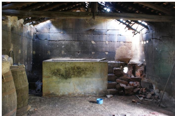
Fig. 195 - Vista interior. Aspecto da cobertura com asnas em paus de eucalipto.
