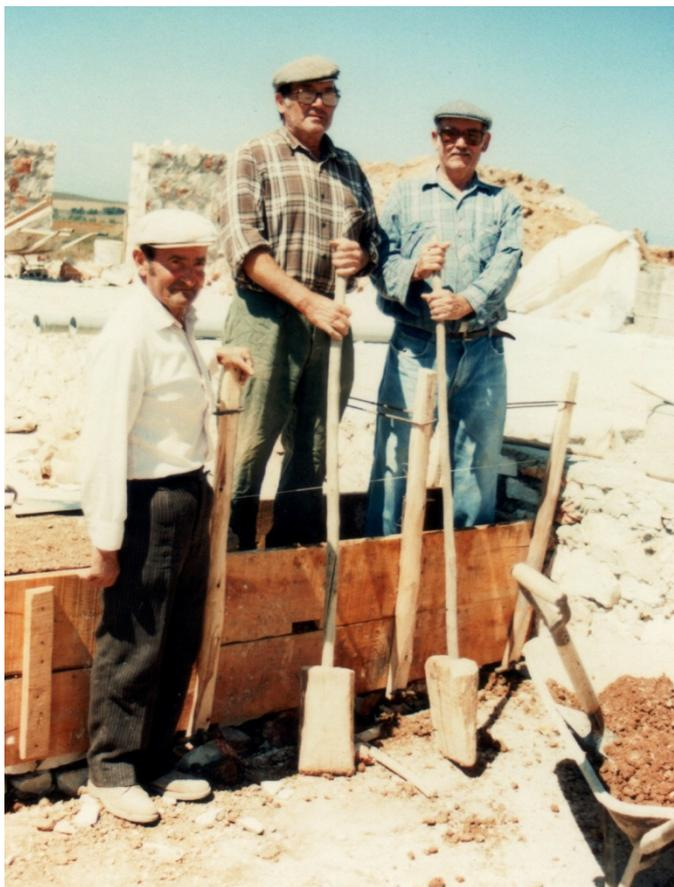
Fig. 46 - Conjunto de duas imagens, representativas da execução de taipa tradicional no Alentejo: montagem de um taipal e apiloar da terra no taipal
