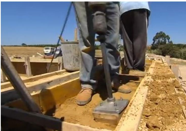
Fig. 113, fig. 114 e fig. 115 Utilização de cofragens corridas em substituição dos moldes tradicionais. Nos cunhais e entre blocos de taipa, deixa de existir o travamento.
