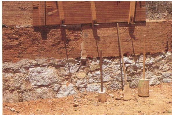
Fig.40 - Fundações em pedra para edifício misto de taipa, pedra e adobe. Aljezur, 1993 [Fonte: Autor.]
