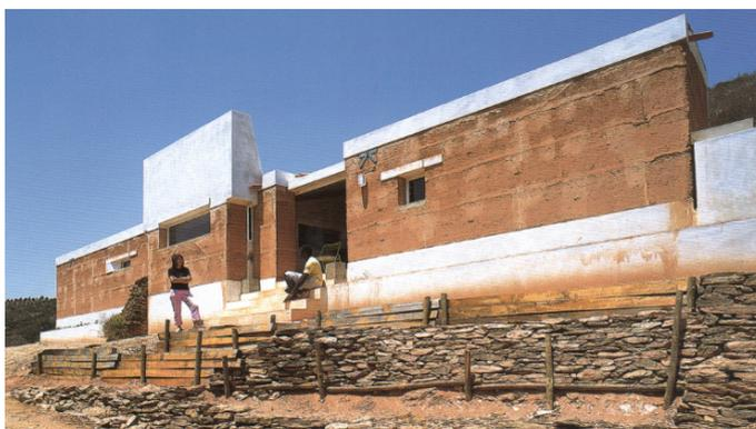
Fig. 84 - Aspecto da empena. Destaca-se o terraço, a pérgula por cima no seguimento da cobertura e a sua complexidade. O vão, em baixo à esquerda, é um reflexo da procura da paisagem em prejuízo do equilíbrio e da estética.
