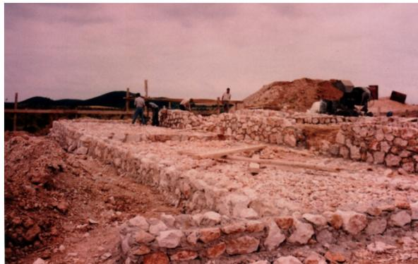
Fig. 41 - Início da taipa sob fundações em pedra com acabamento horizontal irregular, para melhor aderência. Vale da Ripa, Aljezur, 1993. [Fonte: Autor.]
