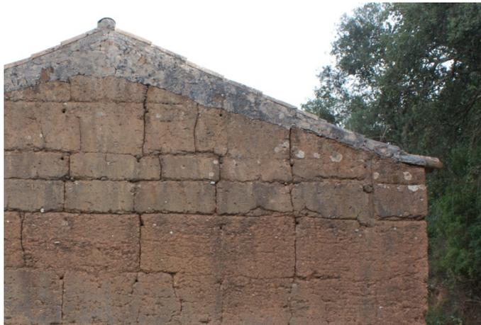
Fig. 210 - Vista interior da parede exterior do palheiro, com algumas fissuras. Neste caso, deve aplicar-se uma rede galvanizada.
