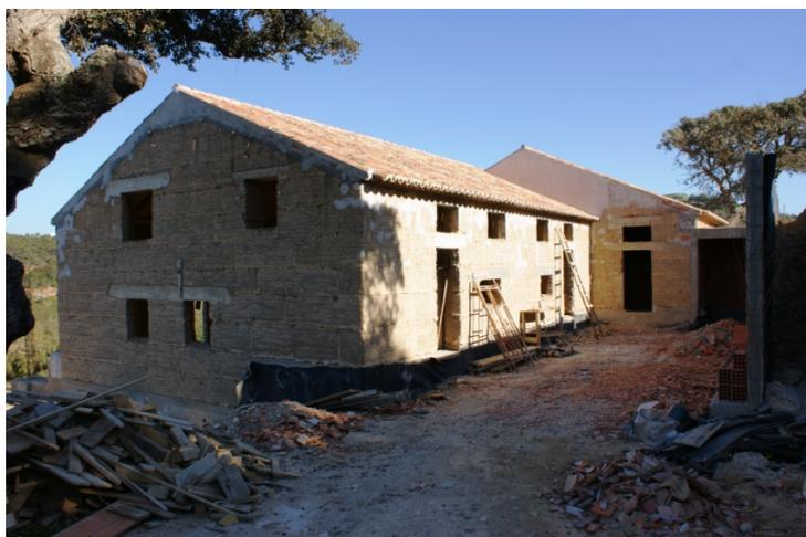
Fig. 141 - Ligação de uma parede em taipa com uma fundação em betão. São visíveis algumas pedras utilizadas como material de transição. O recurso a uma tela drenante (muito mal tratada), pode ser insuficiente.
