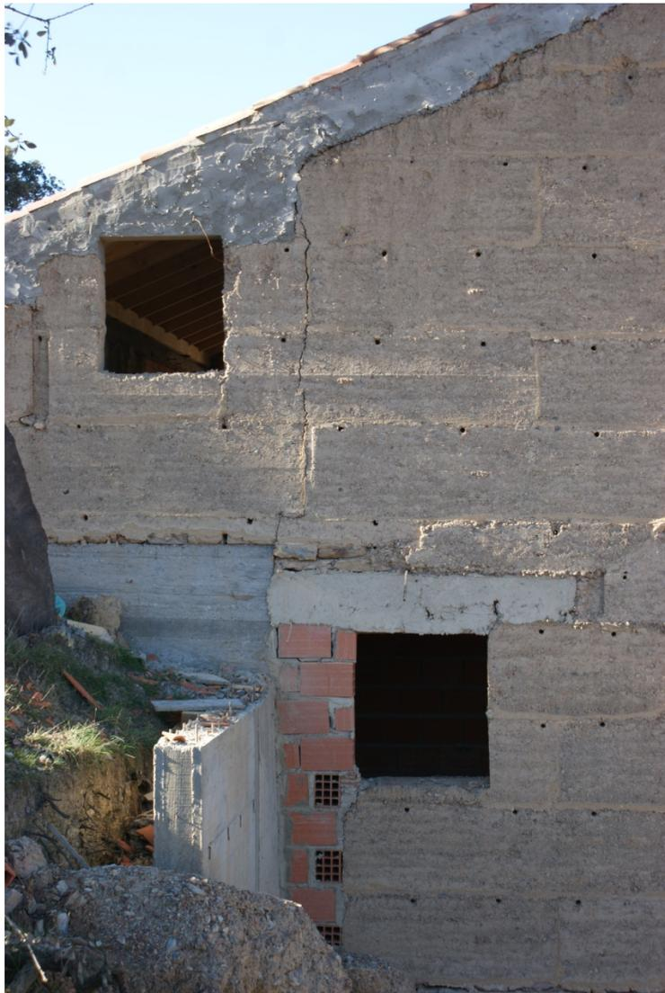
Fig. 143 - Enquadramento do edifício B, existente, objecto de reabilitação. Cobertura de duas águas e baixa contenção volumétrica são aspectos que o caracterizam. Apresenta patologias diversas nomeadamente troços em taipa deslocados do plano vertical, fissuras, ausência parcial e descasque nos rebocos. Não foi possível verificar o estado em que se encontrava a estrutura de suporte da cobertura.
