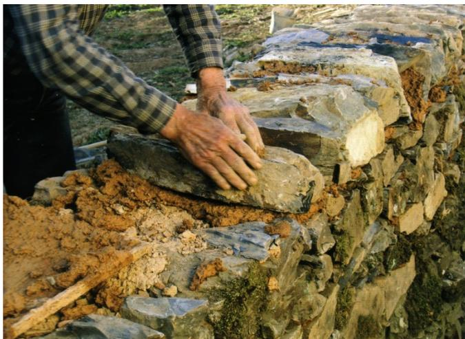
Fig. 52 - Alvenaria de pedra irregular corrigida, Cabeços da Bordeira, Aljezur, 2014 [Fonte: Autor.]
