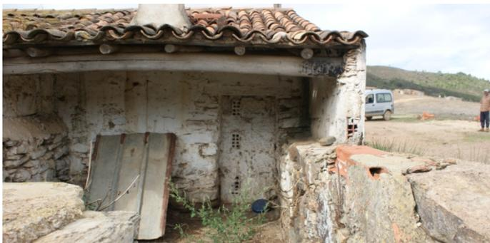
Fig. 208 - Vista 2. Parede do pocilgo em blocos e cobertura em zinco.
