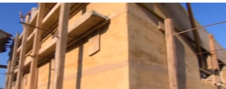
Fig. 116 - As Cofragens metálicas também são utilizadas na construção da taipa, Austrália.
