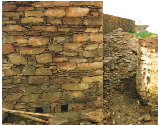
Fig. 55 - Travamento das pedras na execução de uma parede, vista de topo. Odeleite, Castro Marim. [Fonte: Fotografia de Stefano Malobbia, AA.VV. Materiais, Sistemas e Técnicas de Construção Tradicional. Edições Afrontamento, 2008, p.195.]
