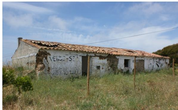
Fig. 36 - O mesmo edifício construído em taipa de solo arenoso à qual foi adicionada pedra miúda como correctivo.
