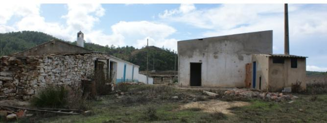
Fig. 199 - Vista 3. Edifício de uso desconhecido construído em alvenaria de pedra e alguns tijolos, tecnicamente mal executada.
