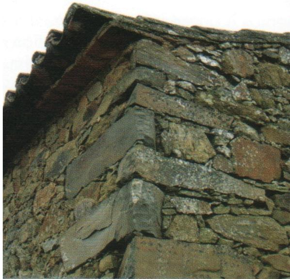
Fig. 54 - Parede em alvenaria de pedra com uma superfície desempena e homogénea, com as juntas apertadas. [Fonte: Fotografia GTAA Sotavento, AA.VV. Materiais, Sistemas e Técnicas de Construção Tradicional. Edições Afrontamento, 2008, p.195.]
