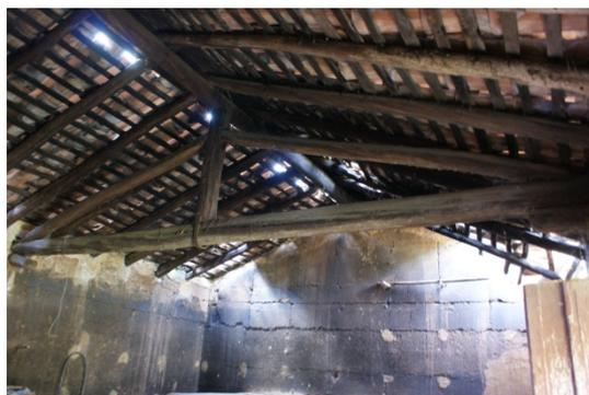
Fig. 64 - Interior da cobertura de um edifício de habitação, com estrutura de paus de eucalipto e canas de suporte das telhas. Serominheiro, Carrascalinho, Aljezur, 2014 [Fonte: Autor.]
