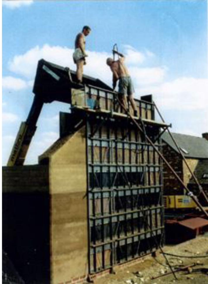
Fig. 117 - Parede de taipa pré-fabricada. Austrália. Deixam de ser executadas *in situ*, com a desvantagem, entre outras, da incorporação da energia gasta na produção e no transporte.
