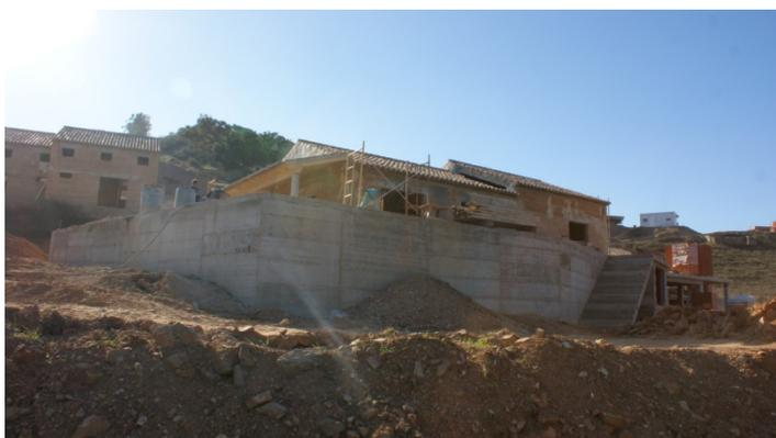
Fig. 131 - Edifício destinado ao restaurante e apoio. Tendo-se por referência a pré-existência, destaca-se a cave em betão armado e o excesso de volumetria, desvanecendo-se as referências pré-existentes.
