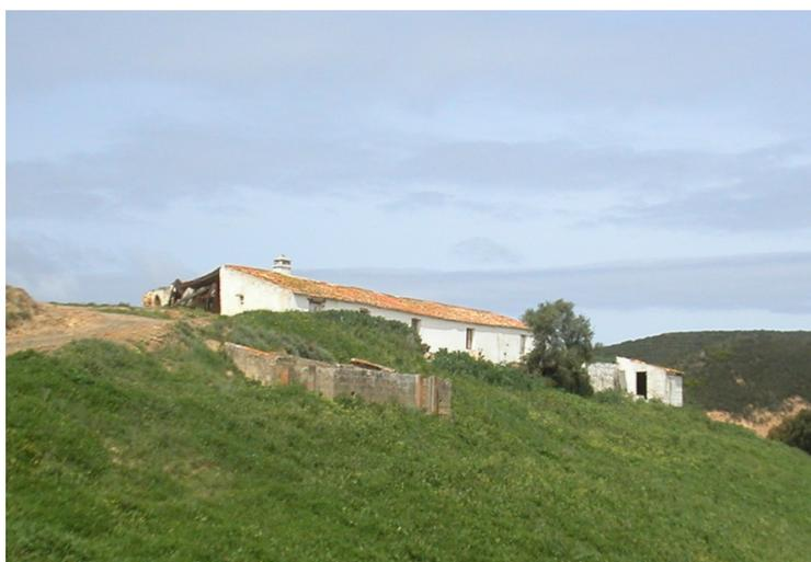
Fig. 144 - Edifício B em reabilitação, após execução da nova cobertura, precedida de uma cintagem em betão armado de apoio das vigas em madeira da estrutura de suporte da cobertura. Mantêm-se as duas águas e a baixa volumetria. Na parede da fachada foram demolidos dois troços de taipa e executados novos blocos em sua substituição. No encontro entre os blocos de taipa antiga e novos, não foi executado travamento.
