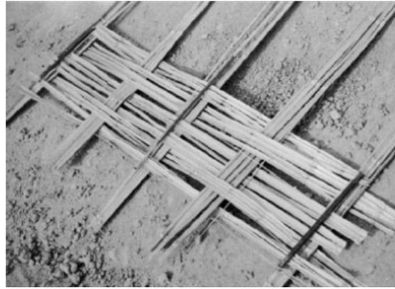
Fig. 67 - Estrutura e forro interior de cobertura, constituída por caibros de azinho e canas. Clarines, Alcoutim. [Fonte: Fotografia de GTAA Sotavento. AA.VV. Materiais, Sistemas e Técnicas de Construção Tradicional. Edições Afrontamento, 2008, p.55.]
