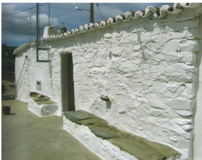
Fig. 77 - Serominheiro, Carrascalinho, Aljezur, 2014. A utilização da cal como exemplo na caiação de paredes em Taipa. [Fonte: Autor.]
