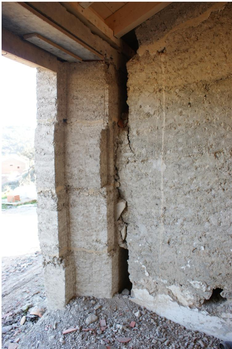
Fig. 148 - Edifício B em reabilitação. Execução de duas aberturas: Não se compreende o tratamento dado à execução do membro entre vãos. O reboco tapa tudo e no final ninguém vê os defeitos.
