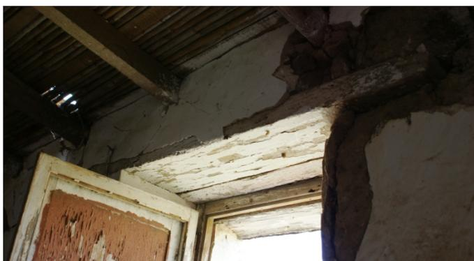
Fig. 48 - Verga e caixilho em madeira com ombreira em tijolo, em Odeceixe, Aljezur, 12014. [Fonte: Autor.]
