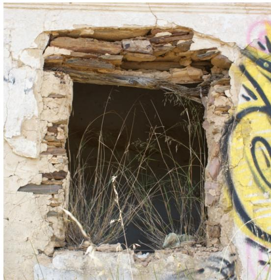
Fig. 58 - Vão de porta de habitação, com ombreiras e respectivas golas em pedra, verga em madeira de azinho e soleira em laje de pedra. Vaqueiros, Alcoutim. [Fonte]: Fotografia de Stefano Malobbia, AA.VV. Materiais, Sistemas e Técnicas de Construção Tradicional. Edições Afrontamento, 2008, p.66.
