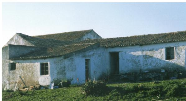
Fig. 32 - Casa em Cabeços da Bordeira junto à estrada, abandonada e vandalizada, duas águas sem chaminé, com estábulo integrado no edifício, paredes mistas de taipa e pedra rebocada, vãos de madeira, contrafortes, e cornija sob o beiral, pouco vulgar em ambiente rural. [Fonte: Autor, 6 de 2014.]
