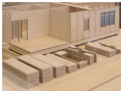
Fig.21 Maquete da estrutura de construção pré-fabricada do tipo *Packaged House*.
