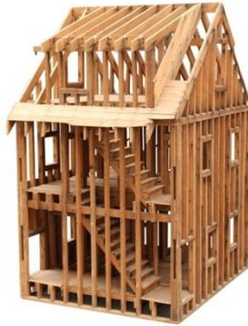
Fig.20 Maquete da estrutura de construção pré-fabricada do tipo *Ballon Frame*.
