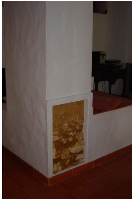
Figura 44: A taipa original. O enrocamento, o início da taipa da parede mestra. E a execução
