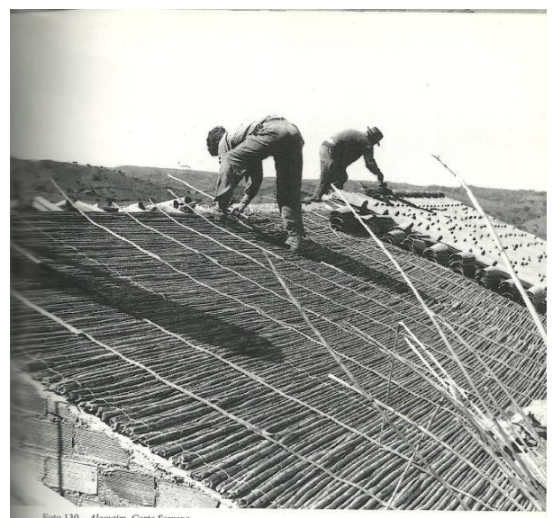
Figura 45: Montagem da cobertura, telha de canudo sobre caniço.
