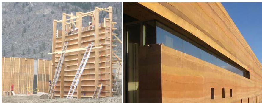
Figura 63 – Construção de parede e edifício em taipa
