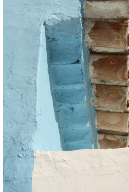
Figura 44: A taipa original. O enrocamento, o início da taipa da parede mestra. E a execução
